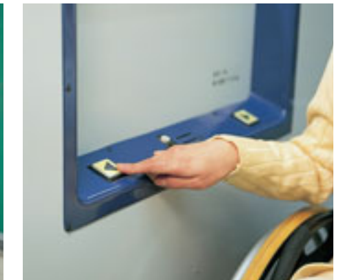
かご内操作ボタン 昇降用ボタン、インターホン、非常停止ボタン付き。
