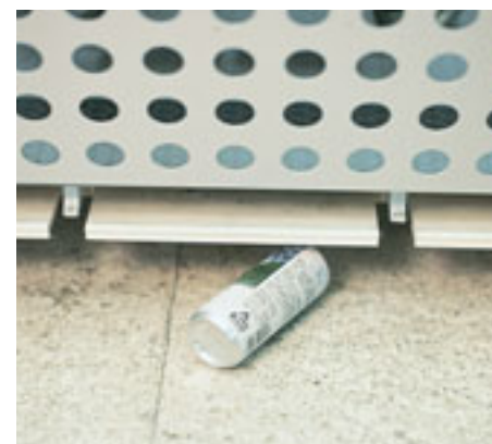
障害物検出装置 かごの下に缶やビンなどの障害物があった時に、運転を停止する安全装置。
