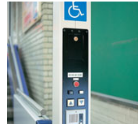
スタンド型操作盤 スタンドには操作ボタンと管理室につながるインターホン付き。
